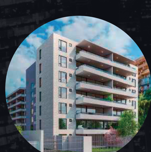
EDIFICIO SUECIA 3005 NUNGÁ
