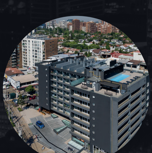
EDIFICIO LAS CONDES 7520 LAS CONDES
