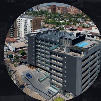
EDIFICIO LAS CONDES 7520 LAS CONDES
