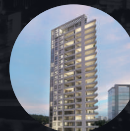
EDIFICIO MIRADOR SOZA BOSQUES DE MONTEMAR
