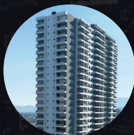
EDIFICIO ALTO PAJARITOS MAIPÚ
