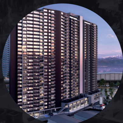
EDIFICIO MACUL ORIENTE II MACUL
