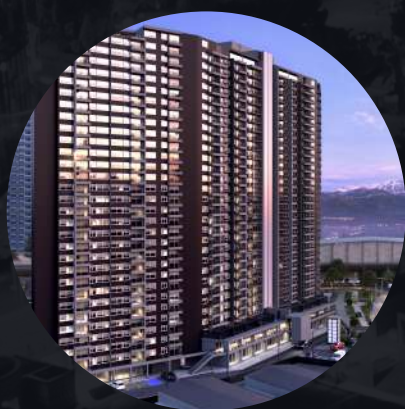
EDIFICIO MACUL ORIENTE II MACUL
