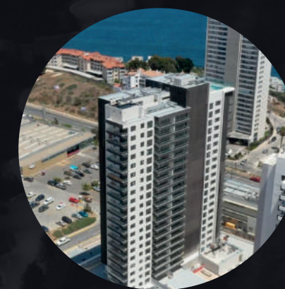
EDIFICIO FIRST RENACA
