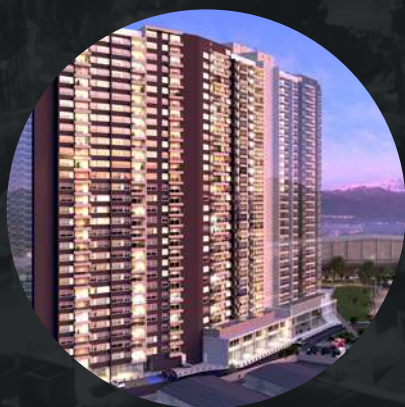
EDIFICIO MACUL ORIENTE II MACUL
