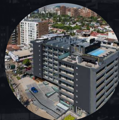
EDIFICIO LAS CONDES 7520 LAS CONDES
