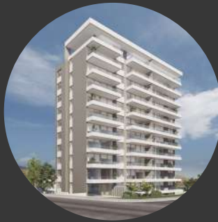
EDIFICIO MIRADOR MONTEMAR, CONCÓN
