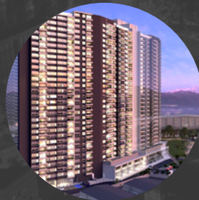
EDIFICIO MACUL ORIENTE II MACUL
